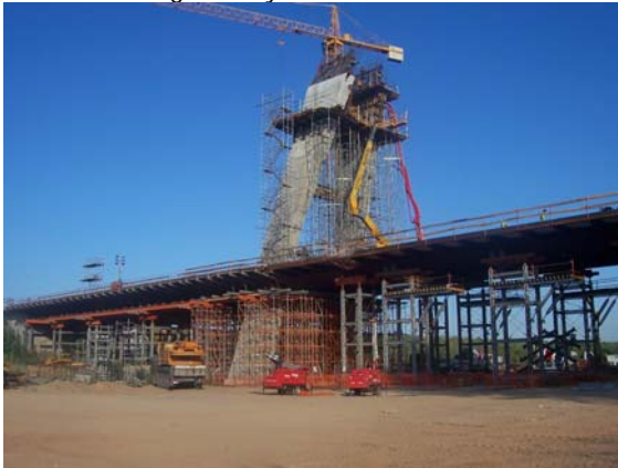
Figura 5. Estado actual de las obras
