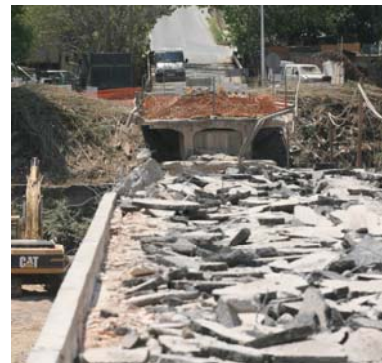
Figura 2. Separación de material asfáltico
