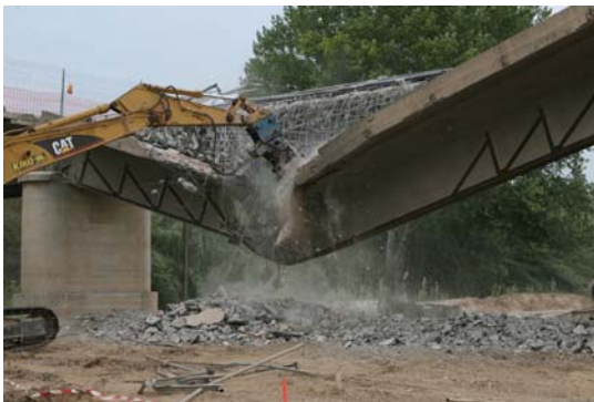
Figura 1. Demolición de la estructura
