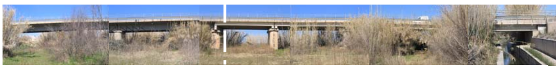
Figura 1. Fotografía del puente actual
